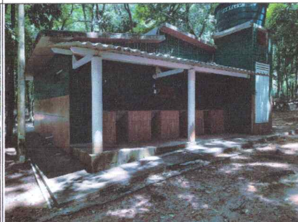
Foto 04: Vista da Lavanderia do Camping (localizada na fachada posterior dos sanitários)
