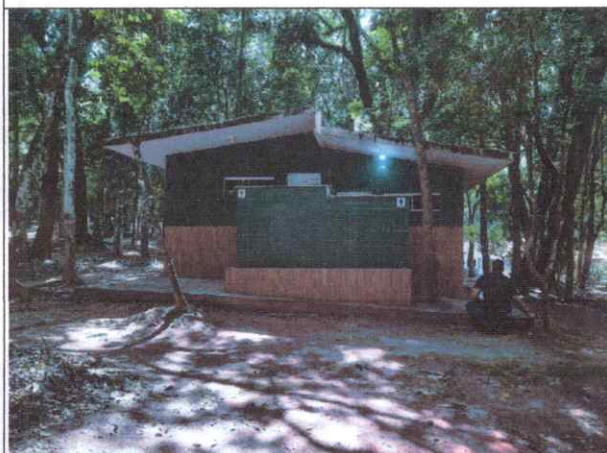
Foto 03: Vista frontal dos sanitários do Camping
