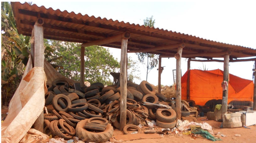
Figura 47: Galpão de armazenamento de pneus no Aterro Sanitário no município de Caconde.
