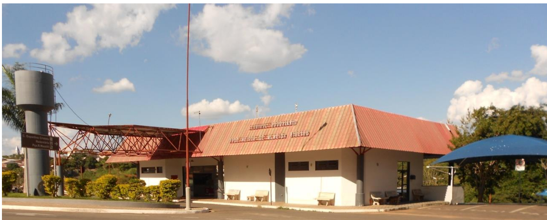
Figura 48: Terminal Rodoviário Municipal.
