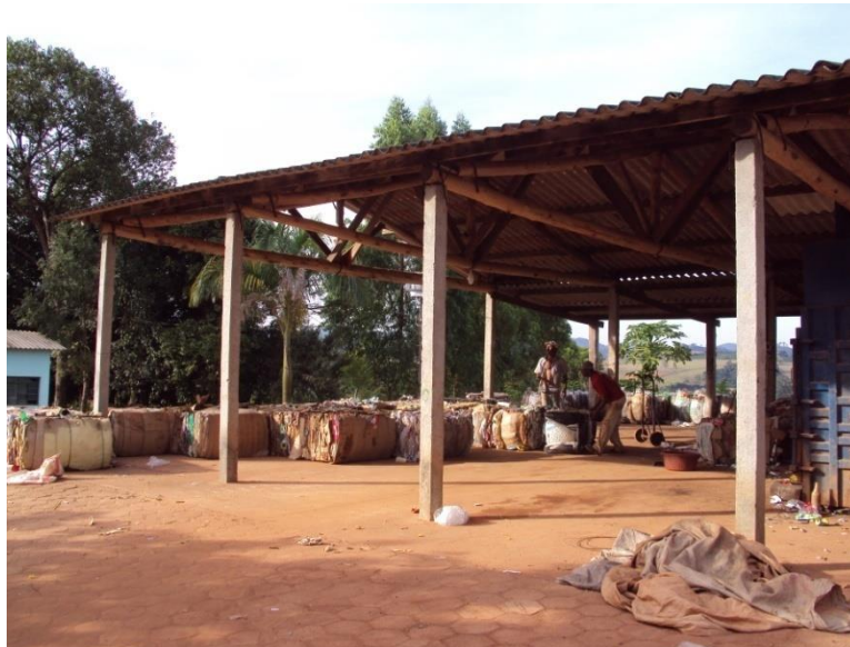
Figura 39: Galpão de separação de material reciclável do Aterro Sanitário/Coleta Seletiva.
