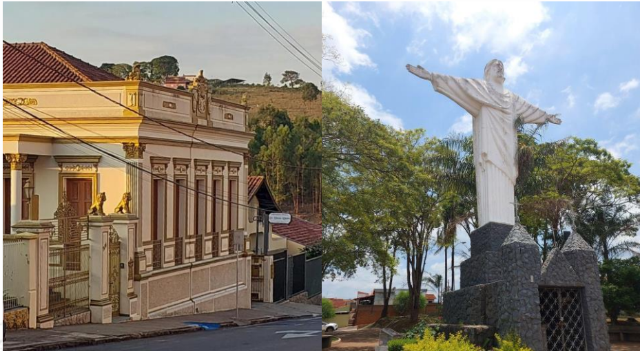
Edifício preservado na área central e Cristo Redentor. (Autores, 2023)
