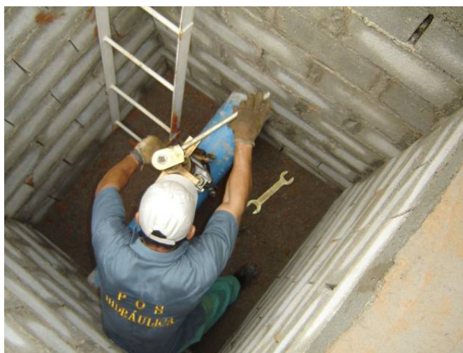
Figura 72. Momento em que a tubulação é furada
