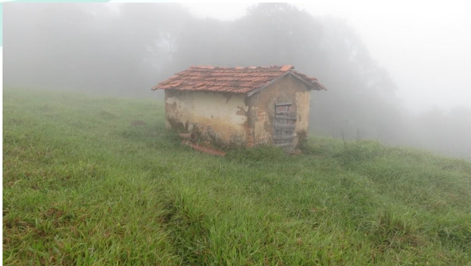
Figura 39 Vista da pequena construção associada ao sistema de captação de água da Serra do Cigano.
