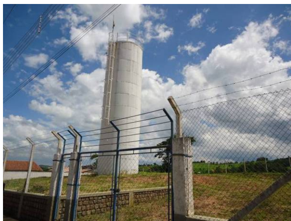
Figura 43. Vista do Reservatório R08
