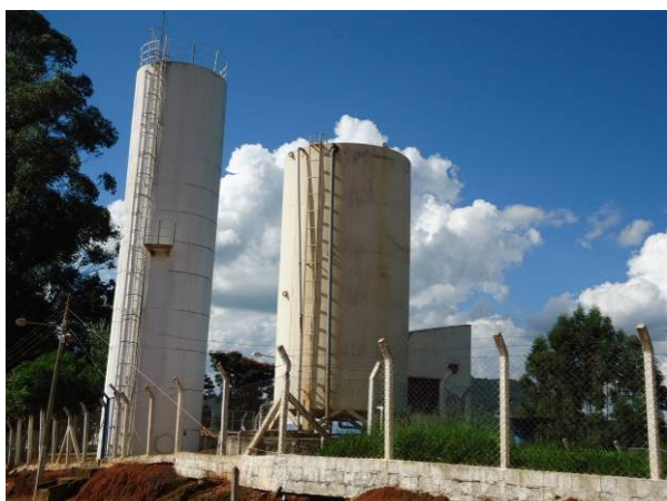
Figura 52. Vista dos Reservatórios em Barrânia
