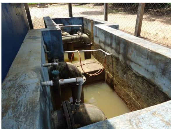
Figura 11. Vista do Poço de Sucção
