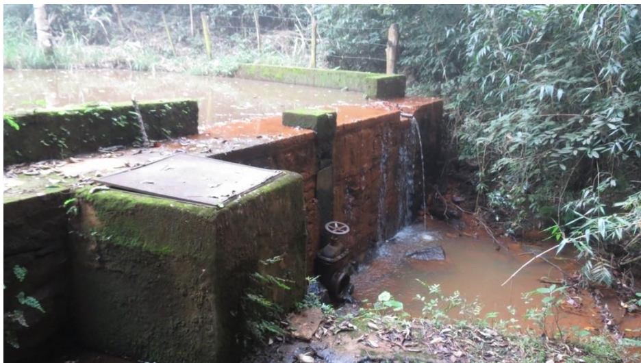
Figura 37 – Vista da pequena construção associada ao sistema de captação de água da Serra do Cigano.
