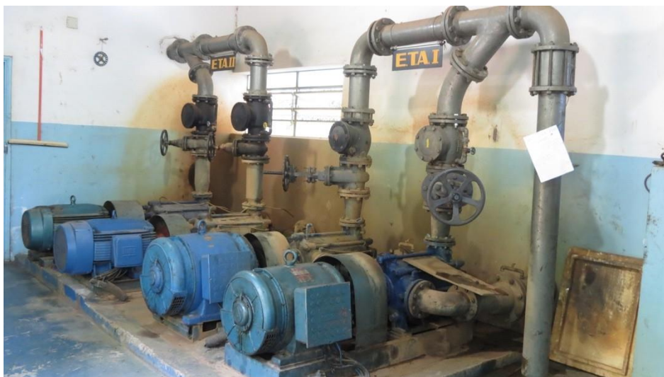
Figura 42 – Vista do ponto de captação e da casa de bombas.
