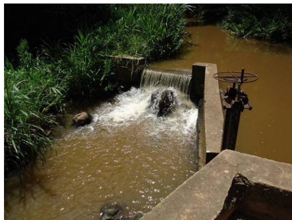
Figura 08. Vista da Captação Córrego da Vaca
