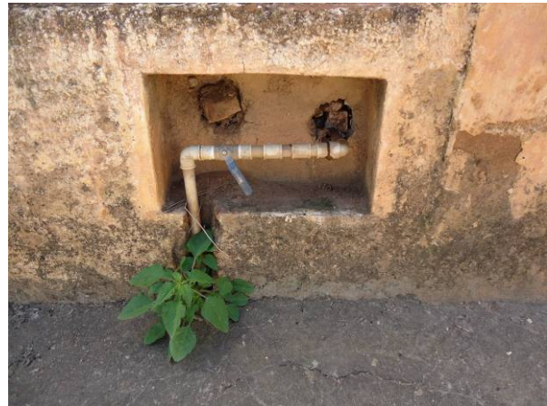
Figura 106. Vista da ligação sem hidrômetro na Rua Elpídio Bernardes Ferreira, nº 47
