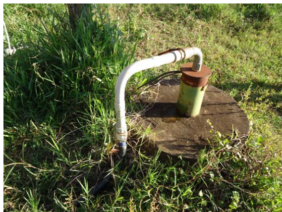
Figura 56. Vista do Poço Mirante
