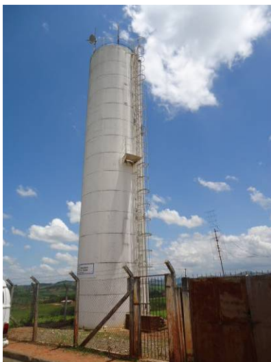
Figura 47. Vista do Reservatório R12
