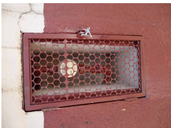
Figura 103. Vista do Hidrômetro na Rua Amador Ribeiro, ao lado do nº 50
