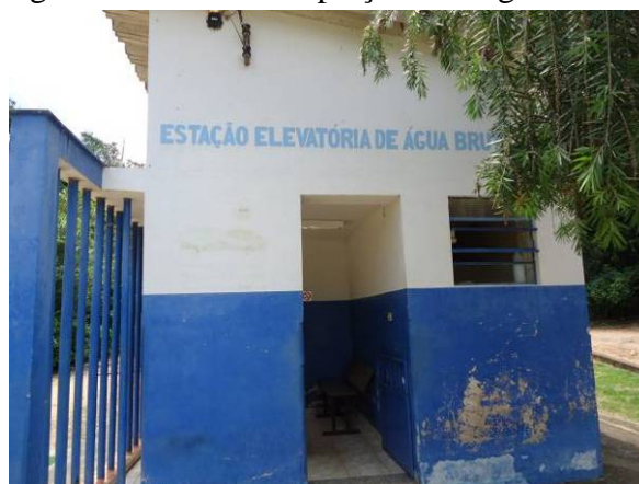
Figura 10. Vista da fachada da Estação Elevatória de Água Bruta
