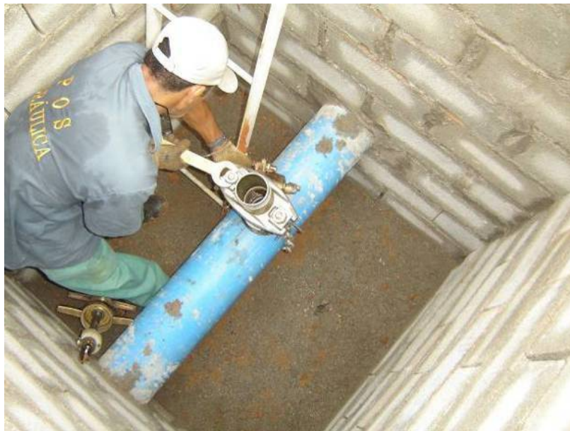
Figura 68. Colocação do suporte da máquina Miller
