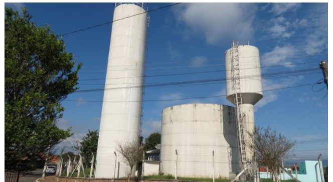
Figura 66 – Reservatórios junto ETA II (730 mil L)
