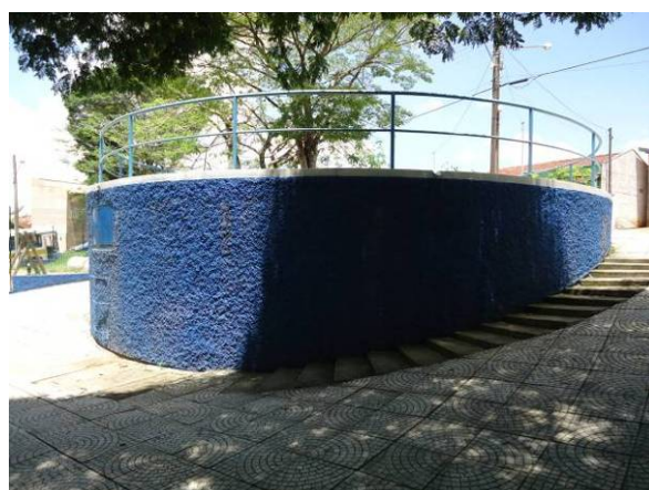
Figura 46. Vista do Reservatório R11
