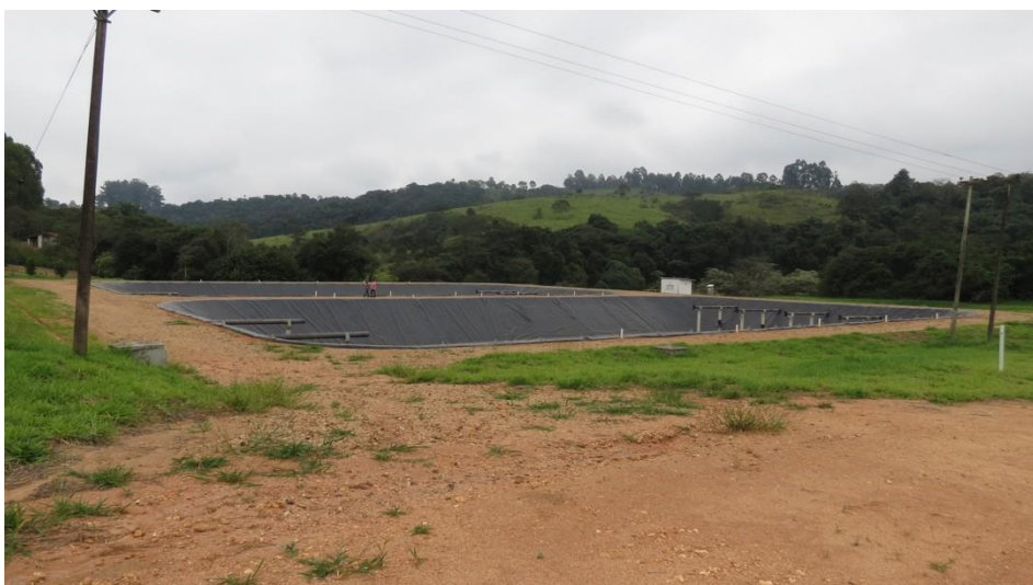
Figura 77 – Lagoas de Sedimentação.
