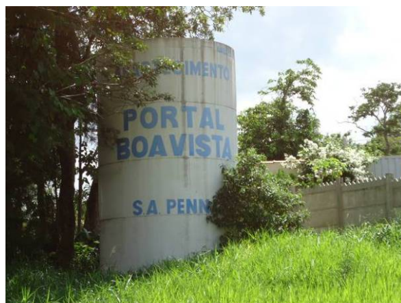
Figura 42. Vista do Reservatório R07
