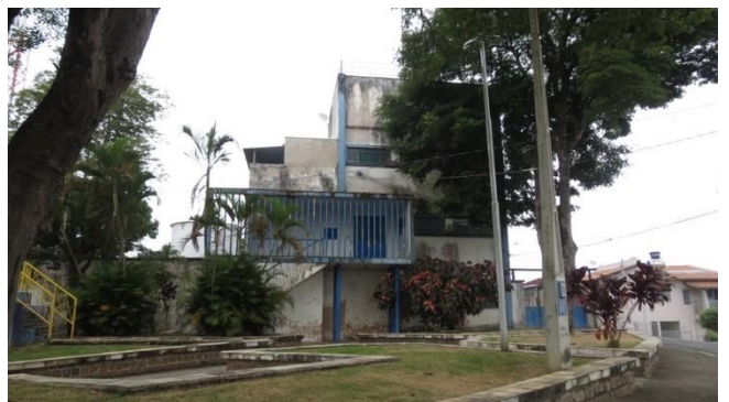
Figura 57 – Reservatório junto a ETA I (50 mil L)
