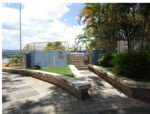
Figura 37. Vista do Reservatório R02
