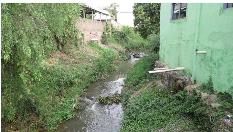
Figura 69 – Lançamento de esgoto Córrego São Miguel.
