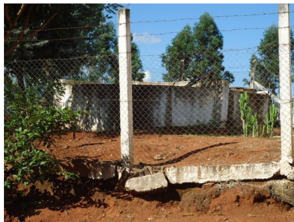
Figura 55. Vista do Reservatório R18
