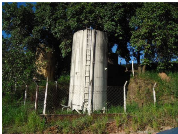
Figura 60. Vista do Reservatório R20 e R21
