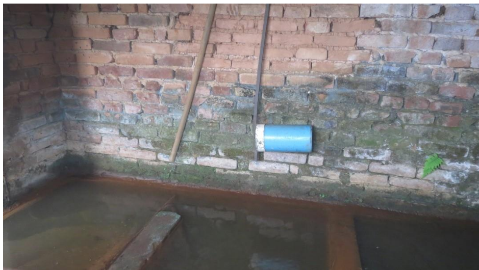
Figura 40 Vista da pequena construção associada ao sistema de captação de água da Serra do Cigano.
