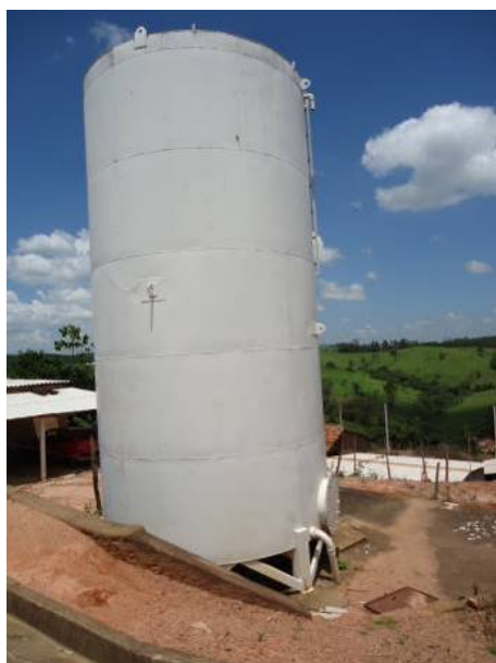
Figura 49. Vista do Reservatório São José
