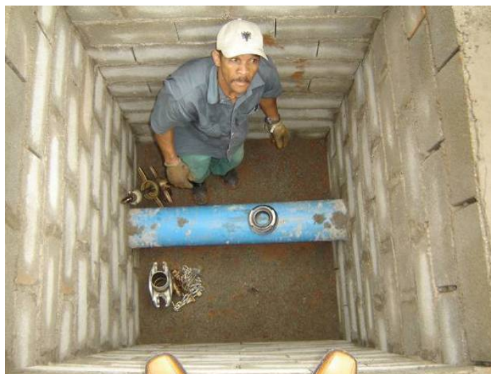
Figura 67. Colocação do anel de borracha
