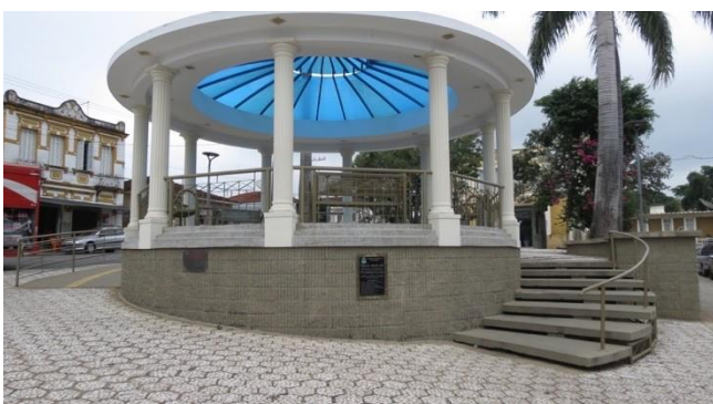
Figura 55 – Reservatório Coreto (100 mil L)
