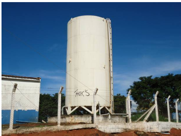
Figura 54. Vista do Reservatório R16
