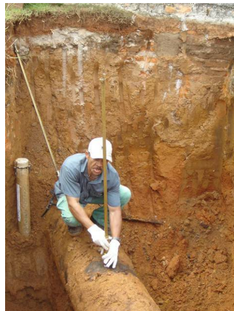
Figura 77. Medição do diâmetro real da adutora com o equipamento Calibre
