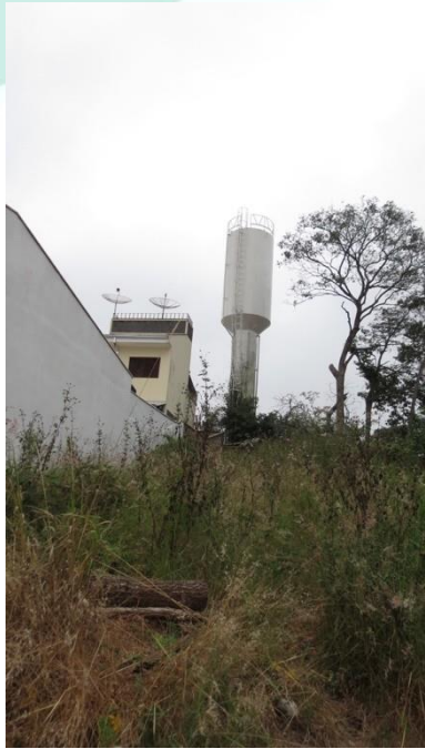
Figura 53 – Reservatório Portal Boa Vista (20 mil L)
