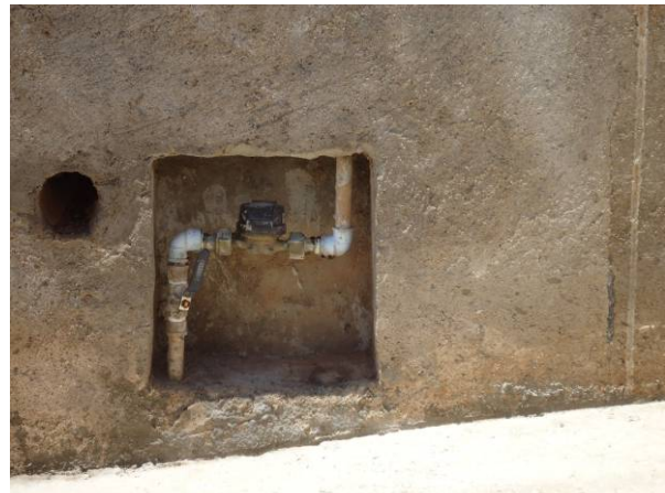
Figura 108. Vista do Hidrômetro na Rua Luis Orrico, nº. 55
