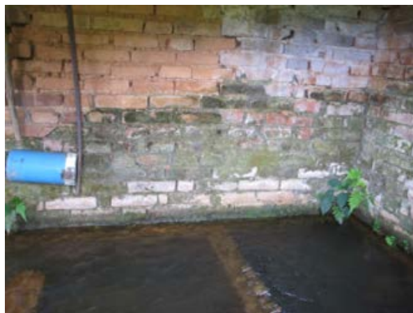
Figura 20. Vista da Captação Serra dos Ciganos
