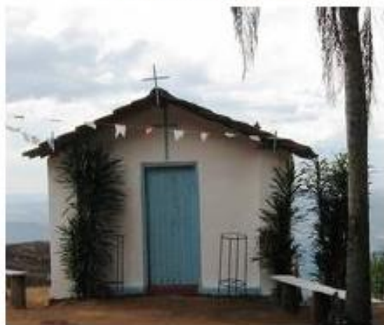
Figura 23- Capela no mirante do Pontal
