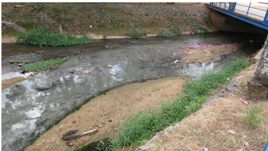
Figura 68 – Lançamento de esgoto Córrego São Miguel.
