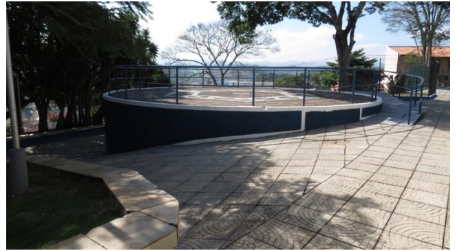
Figura 65 – Reservatório Santa Cruz (500 mil L)
