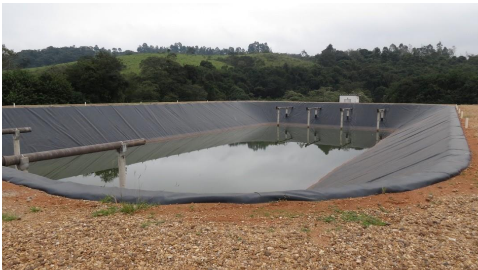
Figura 76 – Lagoa de Sedimentação.
