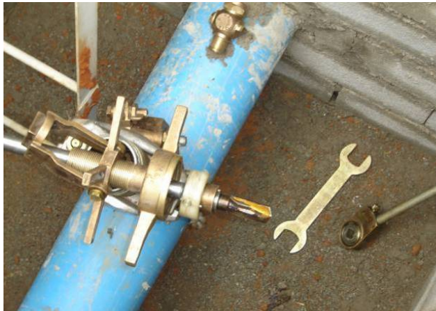
Figura 69. Broca encaixada na base da máquina
