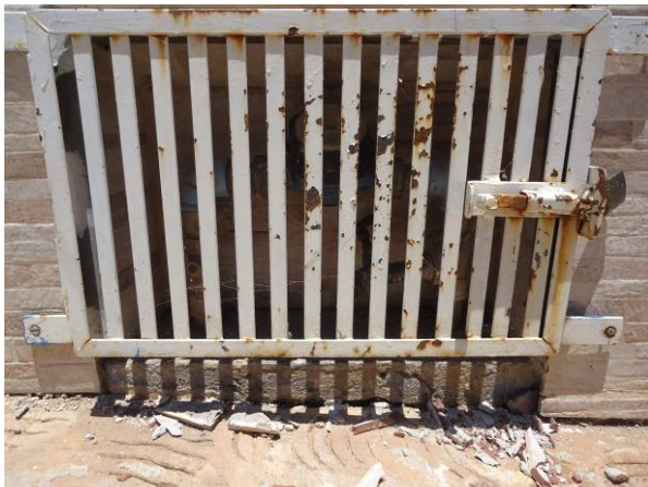
Figura 107. Vista do Hidrômetro na Rua João Orrico, em frente ao nº. 379
