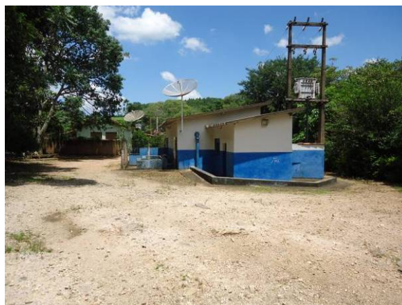
Figura 16. Vista da Estação Elevatória de Água
