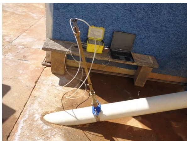
Figura 94. Vista durante as medições 09 e 10
