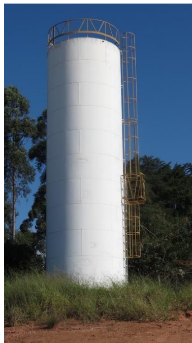
Figura 62 – Reservatório Distrito Industrial (150 mil L)
