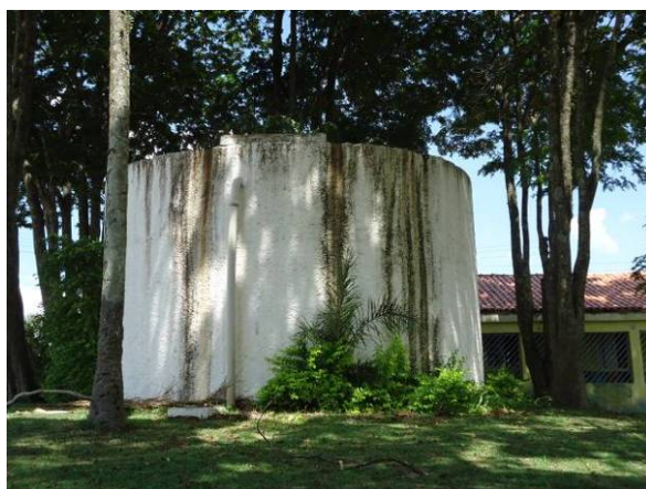
Figura 48. Vista do Reservatório R13
