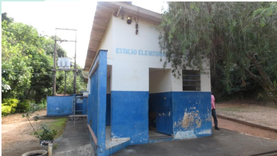
Figura 41 – Vista externa da estação de captação e elevação.
