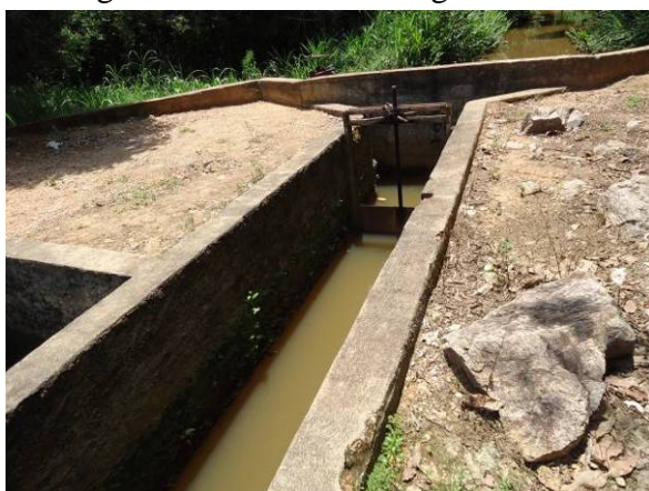
Figura 09. Vista da Captação Córrego da Vaca
