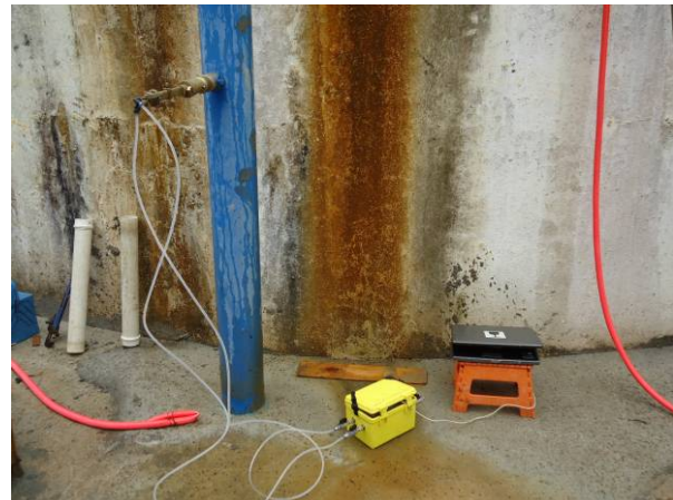
Figura 90. Vista durante as medições 06 e 07
