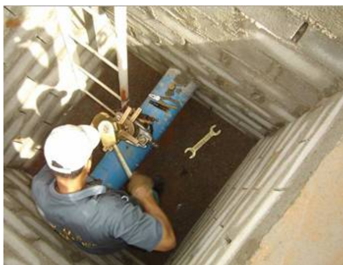
Figura 74. Momento em que a EP está sendo rosqueada na tubulação
