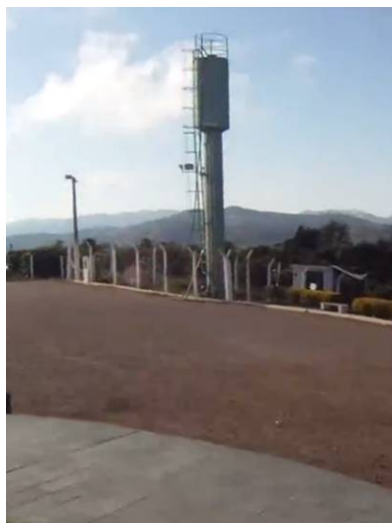
Figura 58. Vista do Reservatório Mirante
