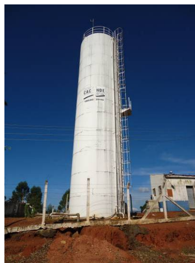
Figura 53. Vista do Reservatório R15
