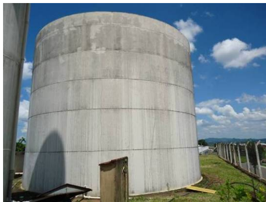
Figura 39. Vista do Reservatório R04
