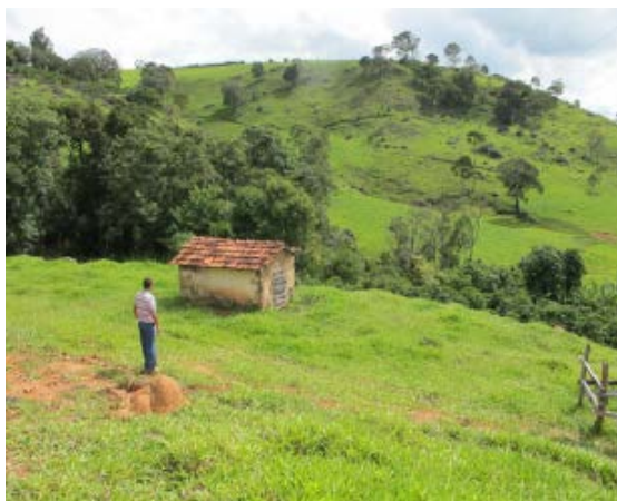
Figura 19. Vista da construção na Captação
