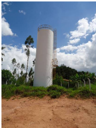
Figura 44. Vista do R09
