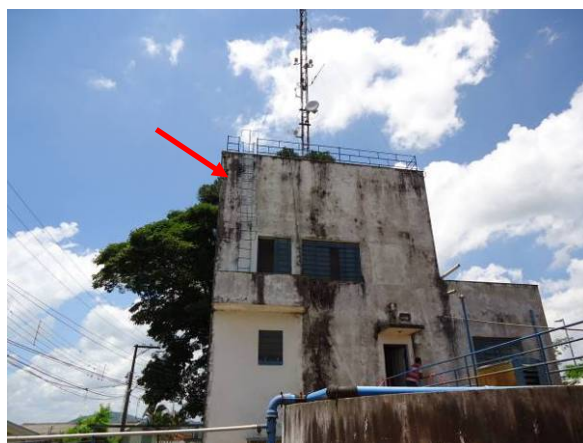
Figura 36. Vista do Reservatório R01
