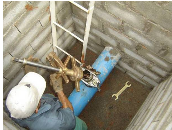
Figura 70. Colocação da máquina no suporte
