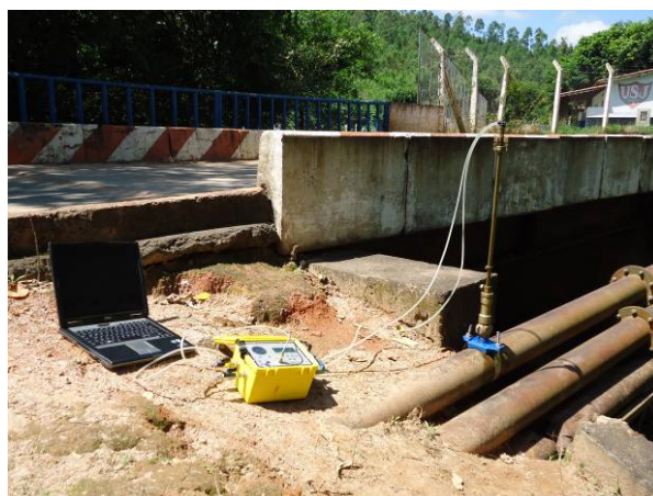
Figura 98. Vista durante as medições 13 e 14
