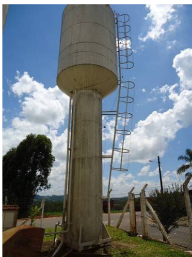
Figura 41. Vista do Reservatório R06
