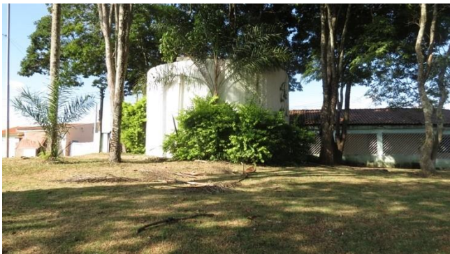
Figura 64 – Reservatório Cristo (30 mil L)
