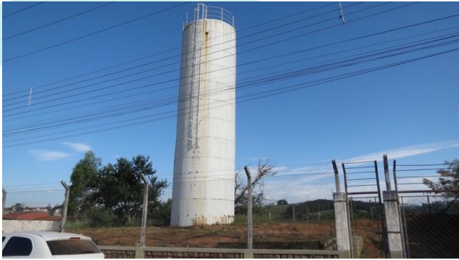
Figura 63 – Reservatório Cadorna Poli (180 mil L)
