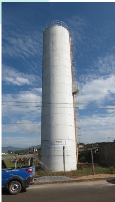
Figura 59 – Reservatório Santa Lucia (200 mil L)
