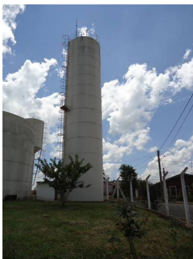
Figura 40. Vista do R05
