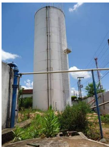
Figura 38. Vista do Reservatório R03
